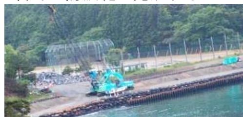
護岸工事が進む荻浜中学校
