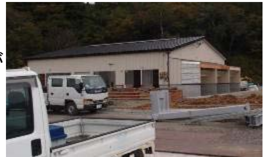
完成が遅れている牡蠣加工用建屋
