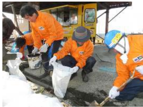
側溝の泥出し～尾形焼きそば店で
