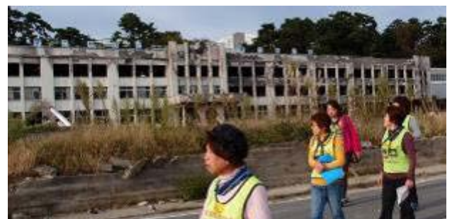
原爆ドームの様な門脇小学校
