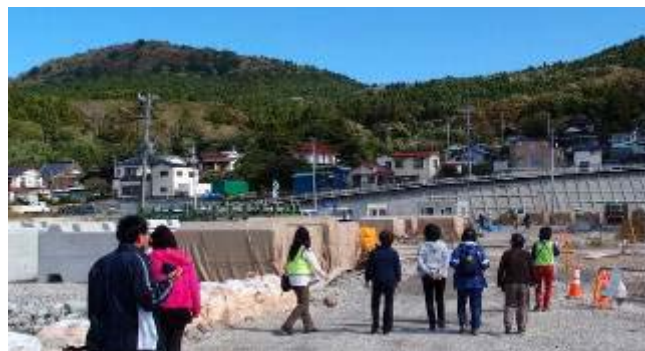
復旧工事が始まった鮎川浜の様子
