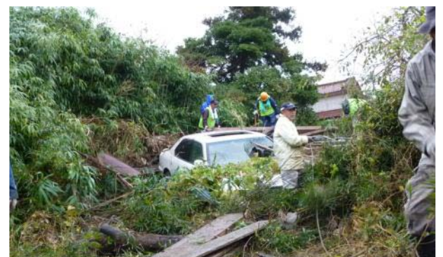
屋根をロープで引き倒し、中に埋まっていた車が現れた場面
