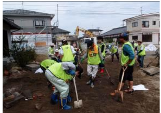
26人で瓦礫処理、となりにショベルカー
