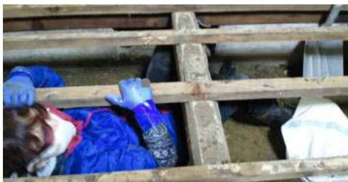
床はがしが終了している部屋の泥掻き作業を終了し、床上に上がろうと体を捻っている様子。床板がある部屋はもぐっていかねばならないとても厳しい仕事になることが分かります
