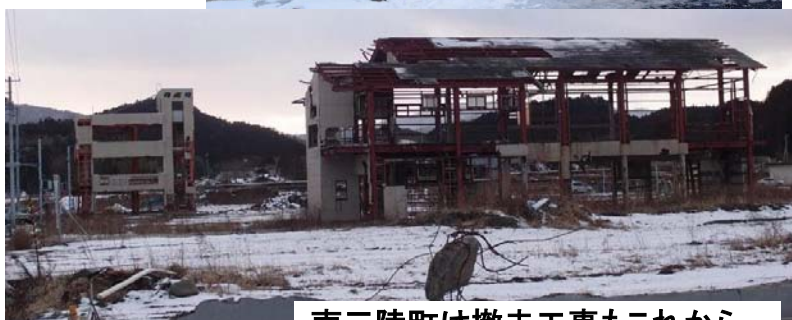
南三陸町は撤去工事もこれから
